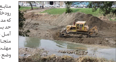
عملیات رفع تصرف از اراضی بستر رودخانه هراز آغاز شد
