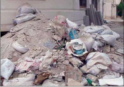
اجرای ضوابط جمع آوری و مدیریت پسماند در حریم راه‌ها و شهرها از چالش‌های دستگاه‌های اجرایی و خدمات رسانی می‌باشد.
