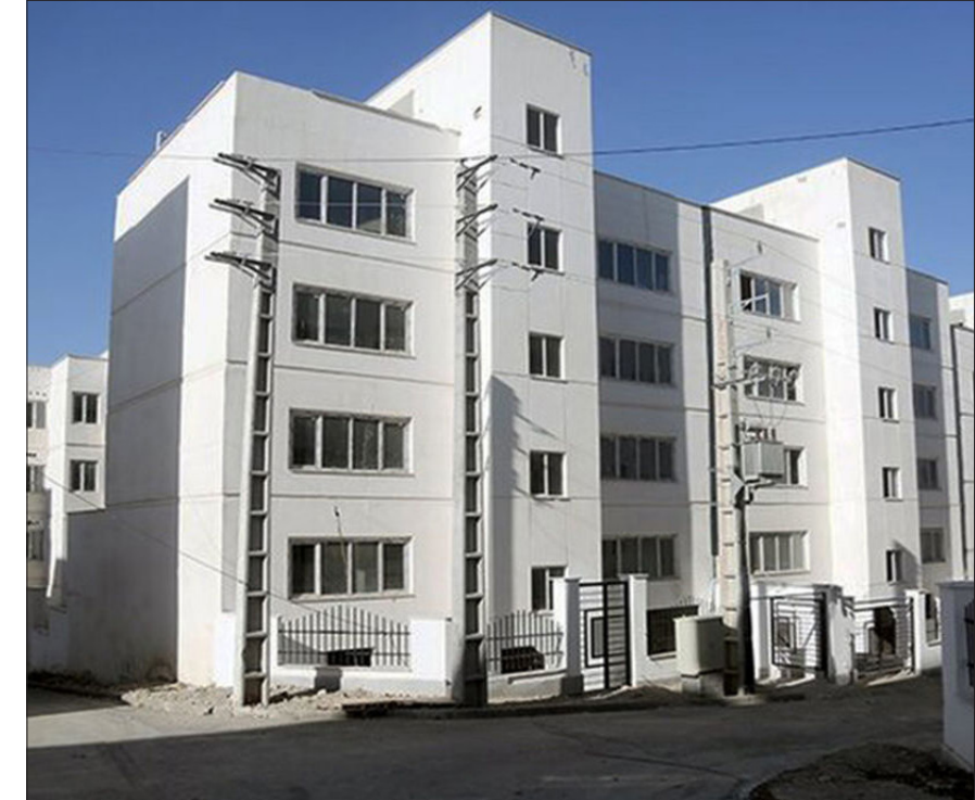
مدیرکل راه و شهرسازی گلستان در بازدید از پروژه مسکن مهر
