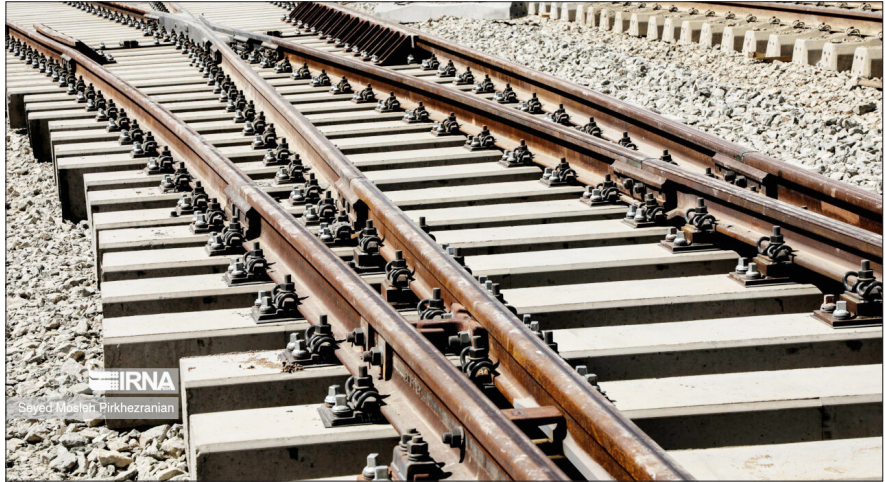
پروژه راه‌آهن رشت- آستارا در حال تکمیل است.
